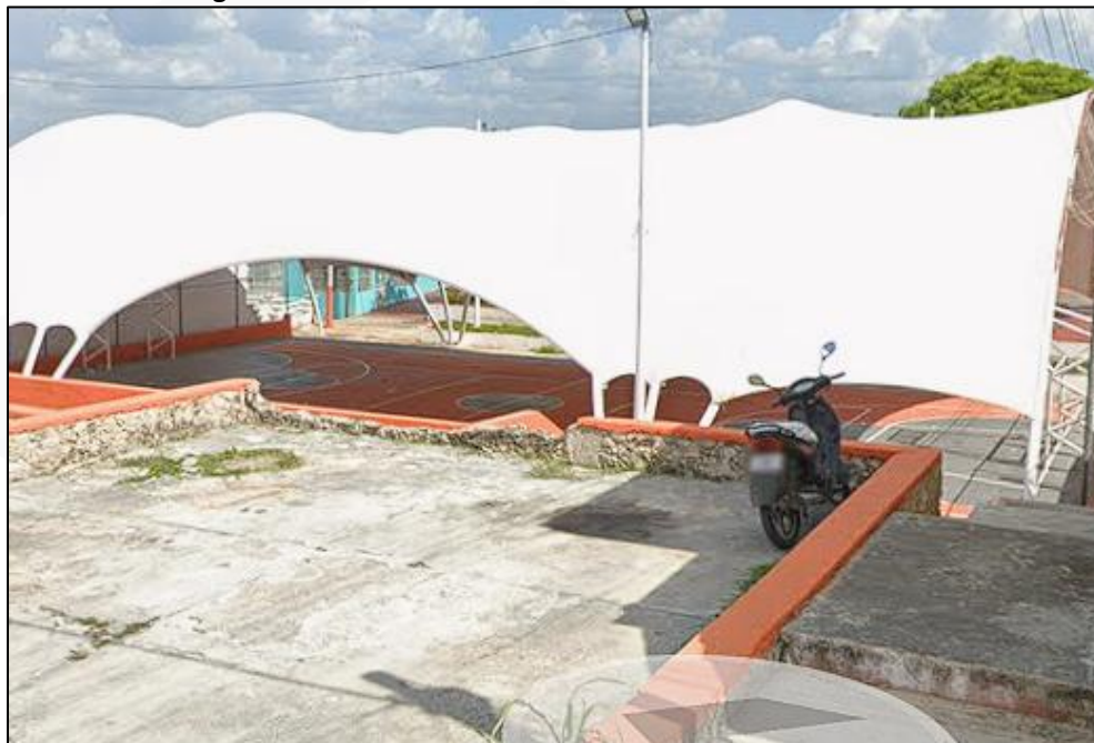
Imagen 70. Vista Lateral de la Cancha Techada Lomas San Rafael
