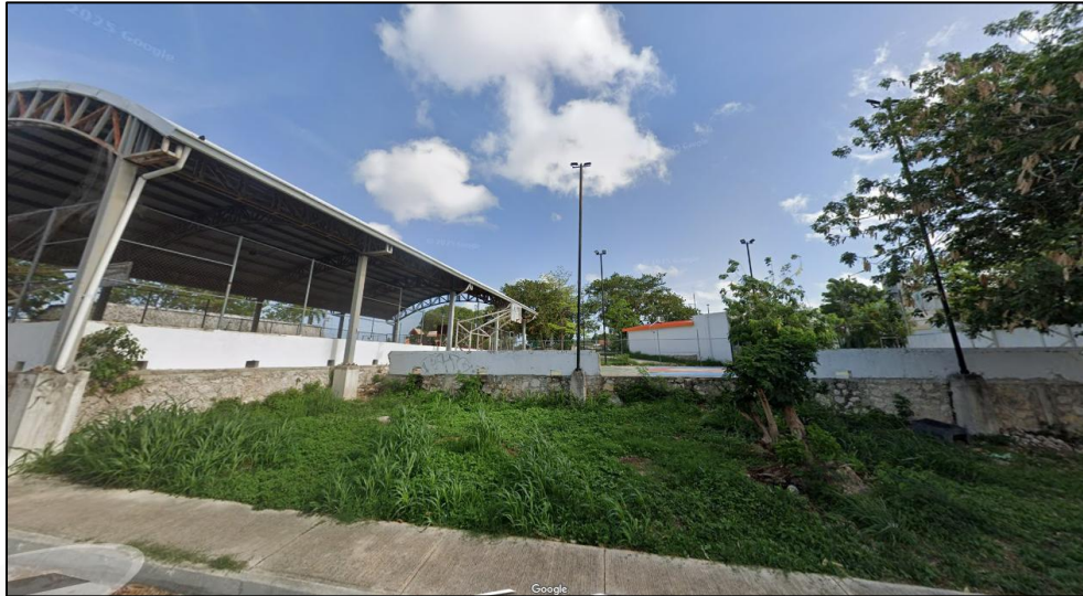
Imagen 81. Fachada de Cancha de uso múltiples Bellavista
