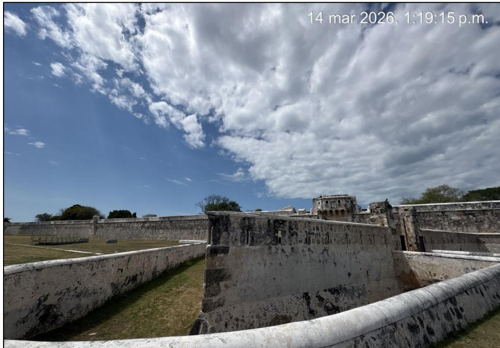
Imagen 8. Vista lateral del Baluarte San Francisco
