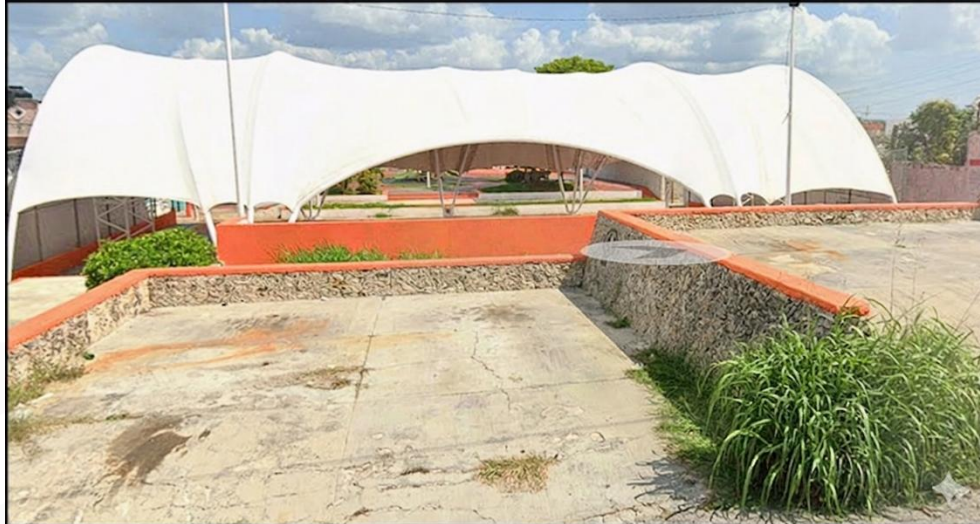
Imagen 69. Vista Lateral de la Cancha techada Lomas San Rafael''
