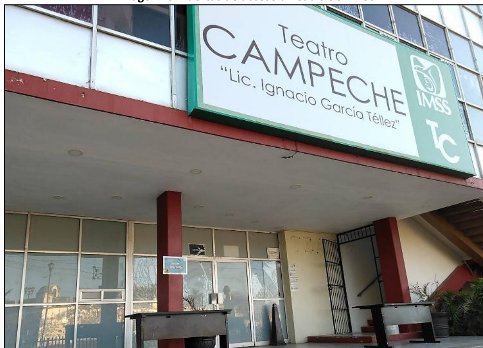
Imagen 26. Puertas de acceso a Teatro del IMSS
