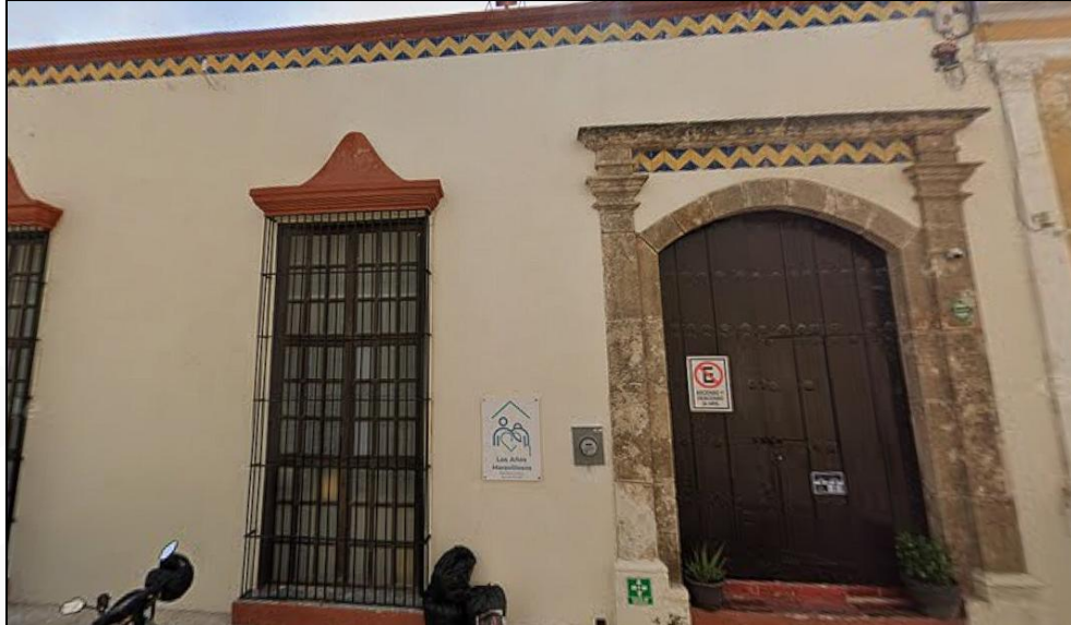
Imagen 59. Fachada del Centro Urbano Residencia de Adulto Mayor “Los Años Maravillosos”
