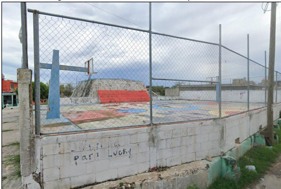
Imagen 88. Fachada de cancha de Usos Múltiples ESPERANZA
