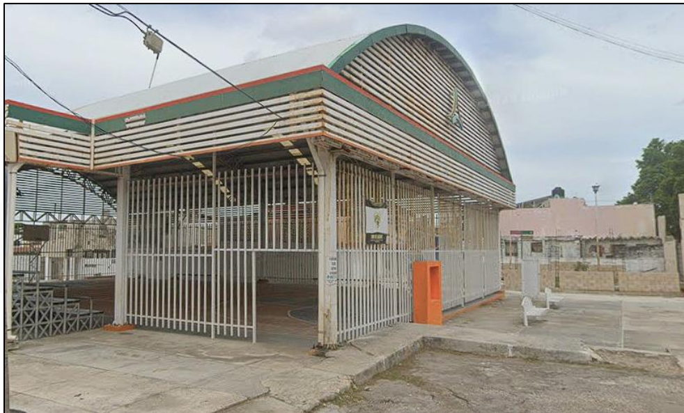
Imagen 74. Vista Lateral de la Cancha de usos Múltiples Mártires de Río Blanco
