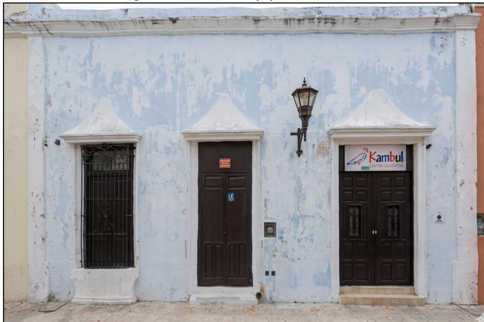
Imagen 45. Fachada del equipamiento "Kambul"
