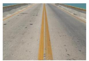
Ilustración 8- Desgaste en Losa en claro
