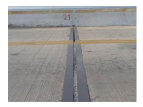
Ilustración 14- Junta de dilatación sobre apoyo, se observa en mal estado
