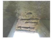
Ilustración 16- Acero expuesto encara transversal de cabezal de pilas
