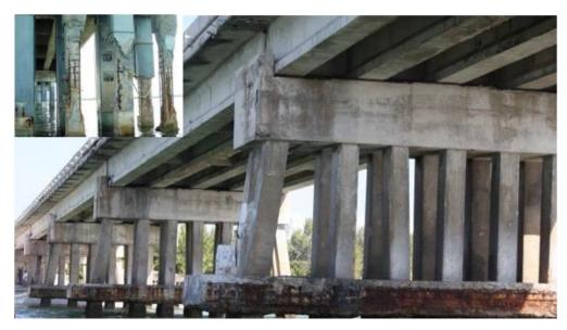
Ilustración 21- Subestructura y condiciones de deterioro
