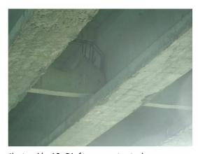
Ilustración 13- Diafragma entre trabe con acero expuesto
