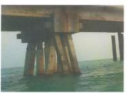
Ilustración 17- Parte inferior de trabes en donde se aprecia que la trabe se colocó contra el suelo sin cimbra.
